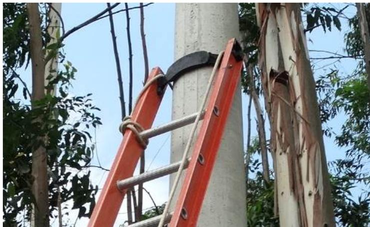
Figura 22 – Posicionamento da escada
