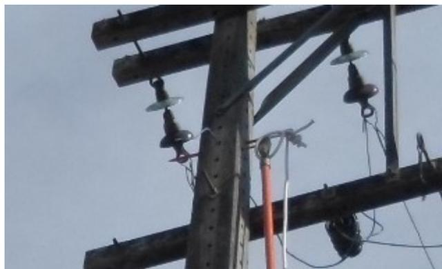
Figura 31 – Instalação do agulhão no poste
