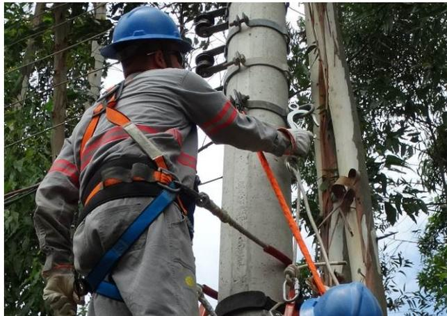
Figura 48 – Fixação do ponto de ancoragem
