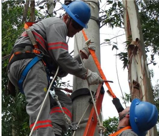
Figura 50 – Corte da ancoragem do trabalhador a ser resgatado
