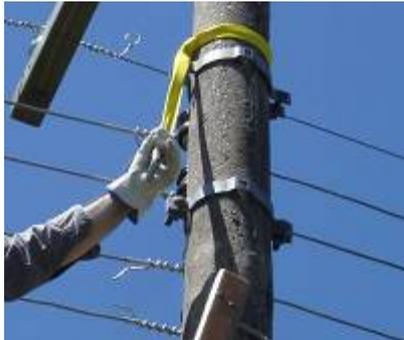
Figura 16 – Ancoragem com fita e mosquetão no poste
