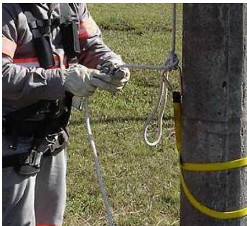
Figura 39 – Instalação do trava-quedas
