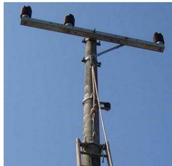
Figura 17 – Ancoragem na ferragem do poste
