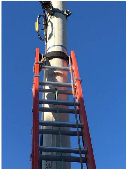
Figura 23 – Posicionamento da escada
